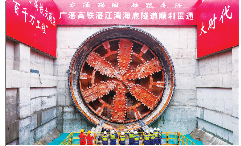
广湛高铁湛江湾海底隧道贯通
