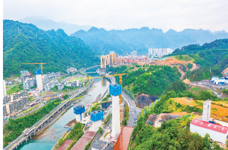
西渝高铁建设高效推进
